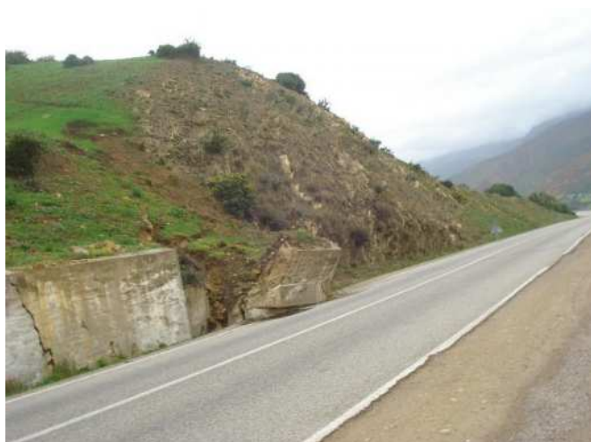
Photos n° 2 et 3: Effondrement différé d'un mur de soutènement
