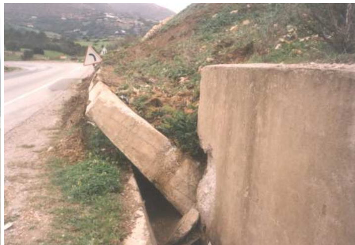
Photos n° 2 et 3: Effondrement différé d'un mur de soutènement
