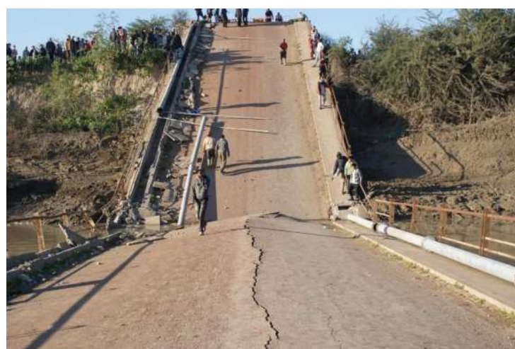
Photo n° 5: Glissement différé dans les marnes
